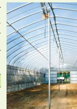
上部に自在クランプ、土台にジャッキを取り付けた支柱。
