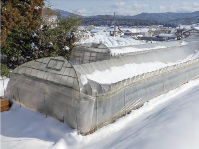
令和5年1月の大雪で倒壊したハウス
