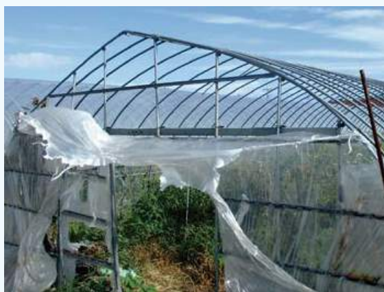
▲昨年8月に発生した台風9号の影響により被覆材に大きな被害を受けた施設
